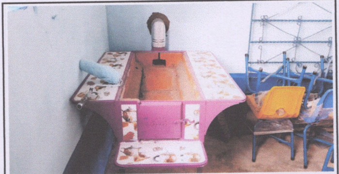
Foto 4: Instalación de nueva plancha de cocina
